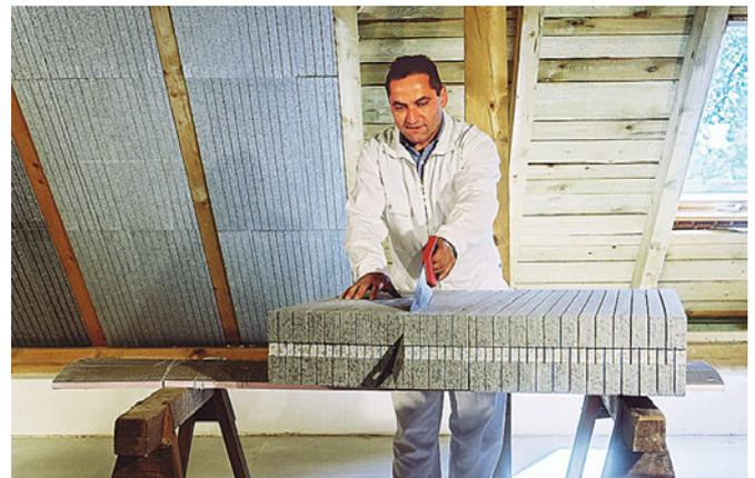
**Austrotherm KLEMMFIX®** i **Austrotherm KLEMMFIX® PLUS** su istovetnih dimenzija kao i standardne termoizolacione ploče (1000mm x 500mm), a proizvode se u debljinama od 80mm do 200mm. S obzirom na neke uobičajene debljine krovnih rogova u Srbiji, najčešće se prodaju ploče debljina 100mm, 120mm i 140mm.
