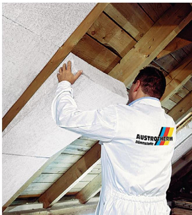
uobičajenim debljinama krovnih rogova u Srbiji – 120mm ili 140mm. Shodno pomenutom Pravilniku, potrebna debljina termoizolacije u kosom krovu iznosi **30cm** (ukoliko koristite **Austrotherm EPS® A30**)! Ta debljina može biti redukovana na **27cm** ukoliko koristite **Austrotherm EPS® AF 60**.
